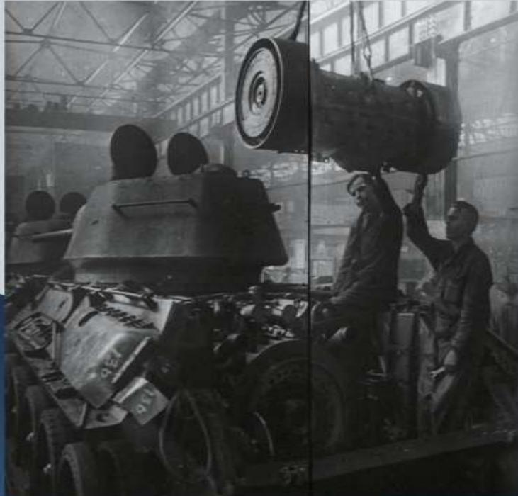
Бригада В. Воробьева, одна из лучших бригад конвейерной сборки танков, ежемесечно выполняет норму на 300-350 %. На конвейере устанавливает коробку скоростей бригадир В. Воробьев (справа). Музей Победы
