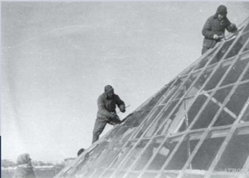
Таврический дворец. Заделка поврежденного светового фонаря над центральным залом фанерой и тонкой жестью. 1943. КГИОП
