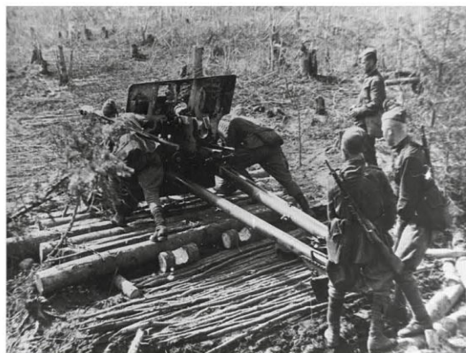
Орудийный расчёт устанавливает пушку ЗИС-3 на новой огневой позиции, используя бревенчатые настилы, в условиях болотистой местности. Белоруссия. 1944
