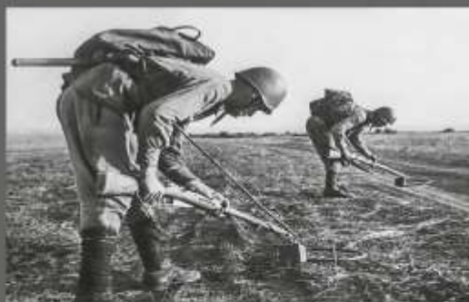
Саперы с миноискателем ВЕМ-203, снабженными на винтовке Мосина
