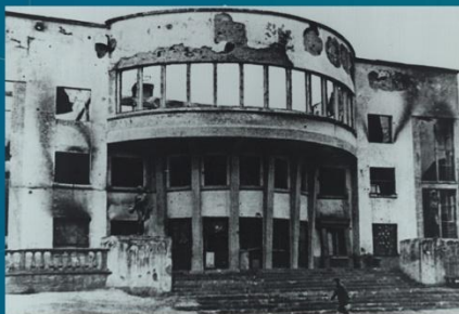
Здание Дворца Культуры имени С. М. Кирова, разрушенное вражескими бомбардировками СССР, Мурманск. 18 июля 1942
