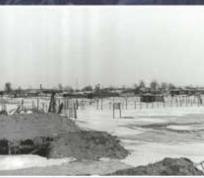
Землянки, построенные советскими военнопленными
